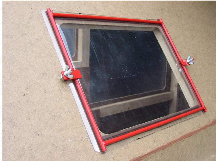
Anschliessend werden die beiden Flügelmuttern angezogen und das Ganze ist garantiert staubdicht verschlossen. Achtung, bei jedem Scheibenwechsel die Gummis immer sauber reinigen, damit nicht Sand zwischen Gummi und Scheibe kommt, der u.U. ein sauberes Abdichten verhindert.
