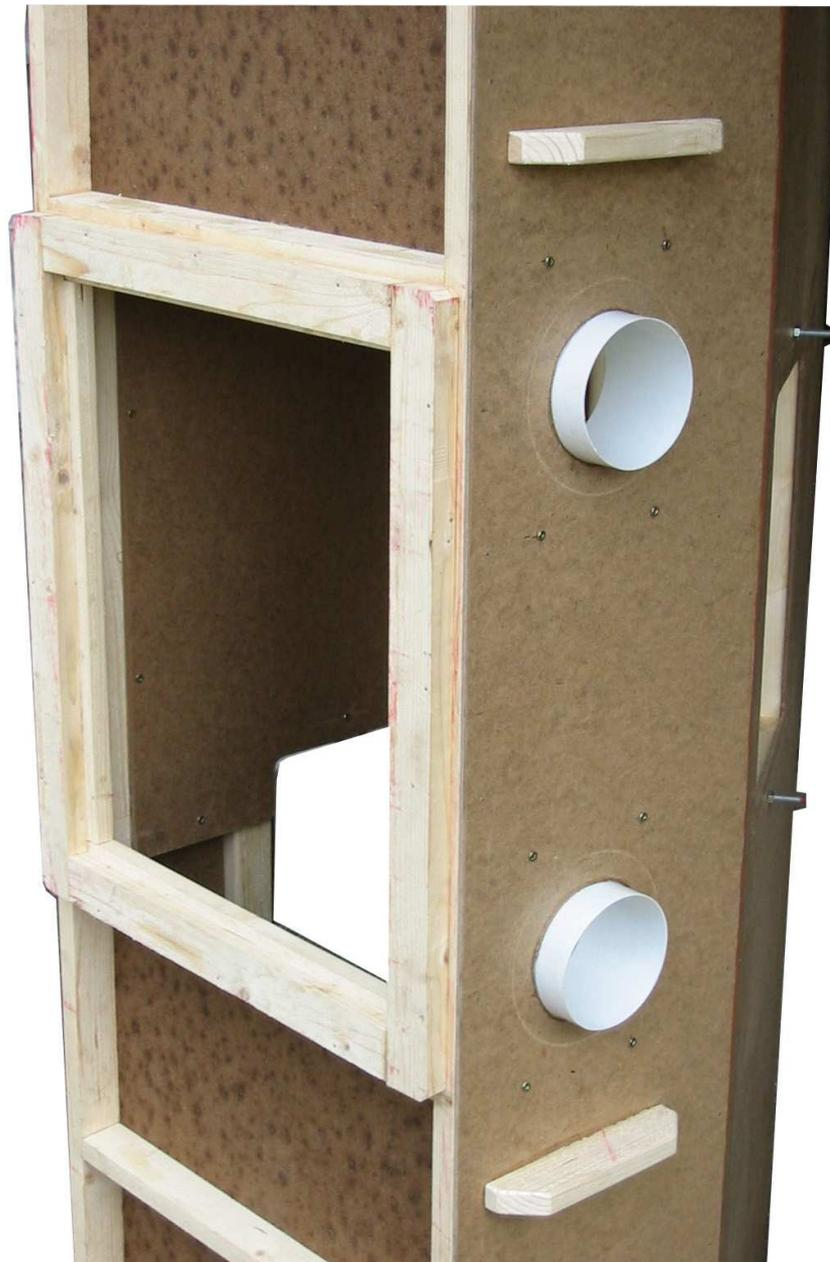
So wird der Rahmen mit dem Kabinenboden verleimt.
