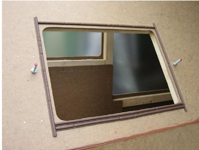
Der zweite Gummi direkt an der Unterkante dient dazu, dass sich nicht allzu viel Sand zwischen Scheibe und Pavatexplatten ansammeln kann. Dadurch fällt beim Wechseln der Scheiben auch weniger Sand auf den Boden.
